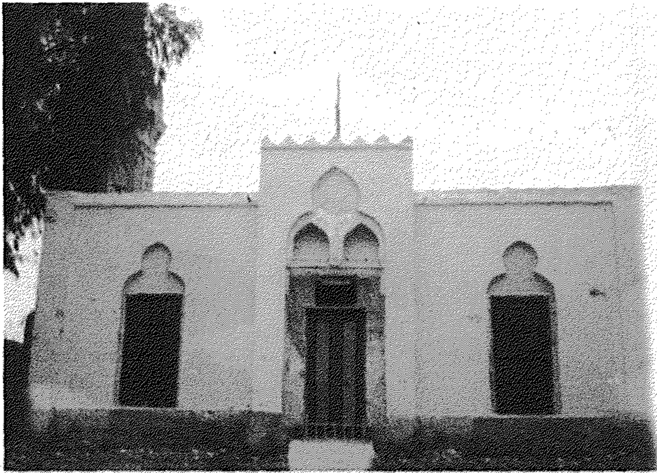
لوحة رقم ( ٤٣ ) : الواجهة الشمالية الغربية لمسجد السلانكلي وتظهر الشبابيك داخل العقد الثلاثي
